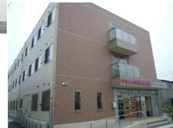
やさしい手東大阪長瀬 運営主体: (株)日建マネジメント
