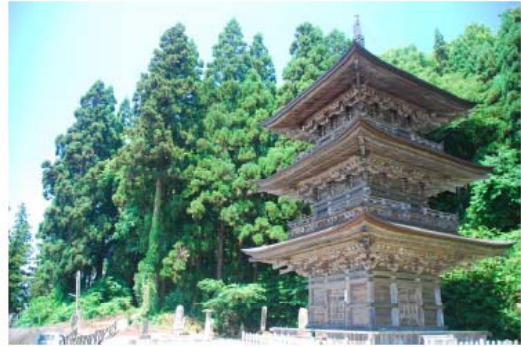
慈恩寺 三重塔
