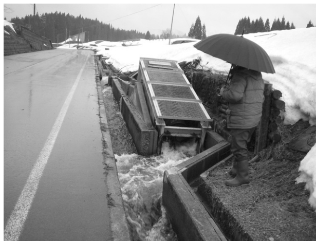
小水力発電 (B) [らせん型。500ワット。落差80cm程度]
