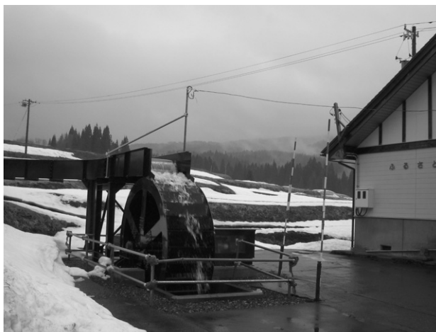
小水力発電 (A) [上掛け水車型。750ワット。落差3m]
