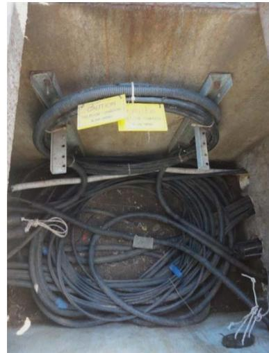
テレコム・カンボジアの光ファイバーケーブル 地下に埋設された基幹線
