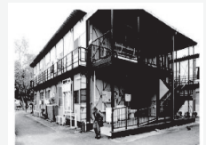
高齢者・障がい者向け 地域型仮設
