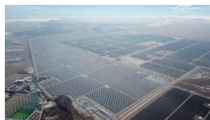
セマングムの発電所
